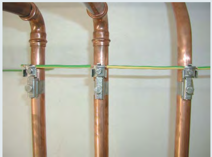
Equipotencialidad en tuberías
