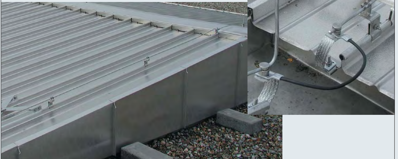
Soporte cubierta metálica
