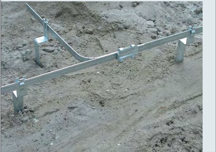
Toma tierra de cimientos
